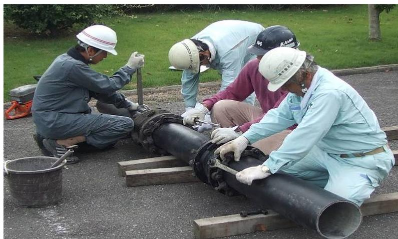
(イ) 応急給水支援設備……県送水管の空気弁設置箇所から学校、避難所などへ仮設配管を設置し、仮設給水栓より応急給水ができるようにするものです。(一部地域は運搬給水となります。)
